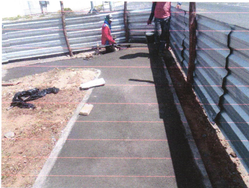
Foto 08 - PAVIMENTAÇÃO EM CONCRETO, COM ESPESSURA DE 7 CM, COM ACABAMENTO FEITO UTILIZANDO ALISADORA DE CONCRETO (HELICOPTERO), INCLUIDO TELA DE AÇO SOLDADA NERVURADA CA60, Q196 (3,11 KG/M 2 ), DIAMETRO DO FIO 5.0 MM, LARGURA = 2,45 M, ESPAÇAMENTO DA MALHA = 10 X 10 CM, JUNTA DE DILATAÇÃO EM PVC A CADA 2,00 M, CONCRETO FCK = 20 MPA
